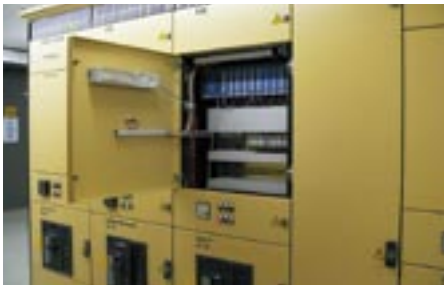
Direkt in der Energieverteilung eingebaute Komponenten und IO-Klemmen für Türmanagement. Quelle: BUS-House
