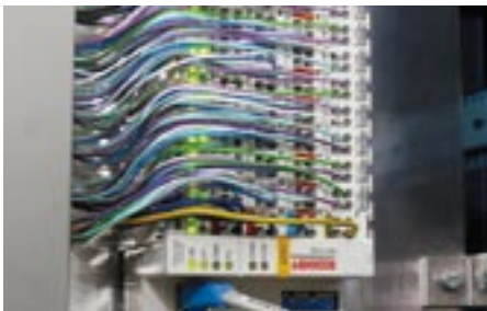
Direkt in der Energieverteilung eingebaute Komponenten und IO-Klemmen für Türmanagement. Quelle: BUS-House
