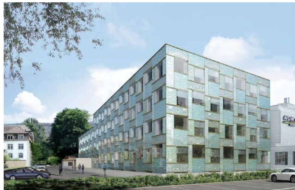
Wo heute die Baustelle ist, dürfte es nächsten Sommer etwa so aussehen, wie diese Visualisierung des neuen NOK-Bürogebäudes zeigt. Besonders augenfällig ist die Fassade mit sandbestrahltem Glas (unten).
